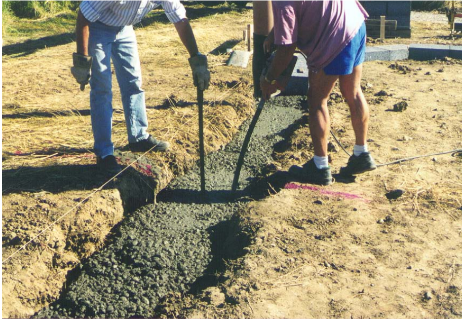
Figur 2: I støbning af bund forankring
