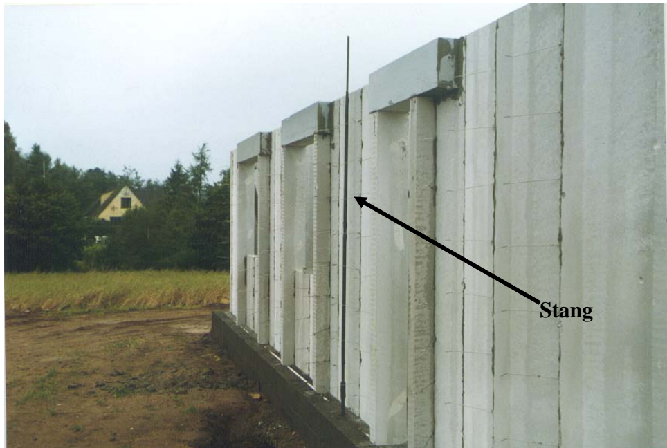
Figur 3: Topstang placeret i bundforankring
